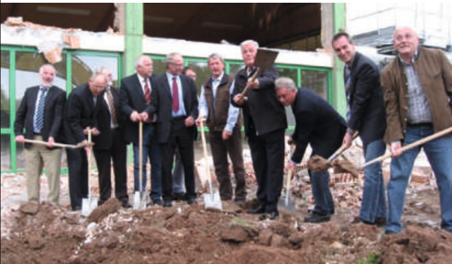
Spatenstich zu Beginn der Baumaßnahme in 2010.
