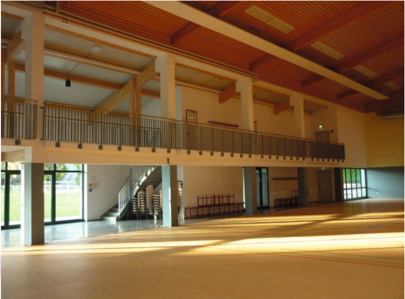
Innenbereich der Halle nach dem Umbau.
