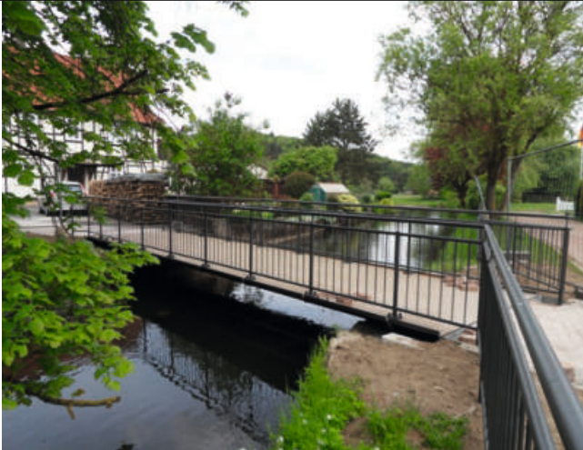
Orpe-Brücke an den Kirchplatz angrenzend.
