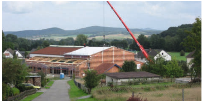
Die Mehrzweckhalle während der Baumaßnahme. (Fotos: tvkuelte.de)
