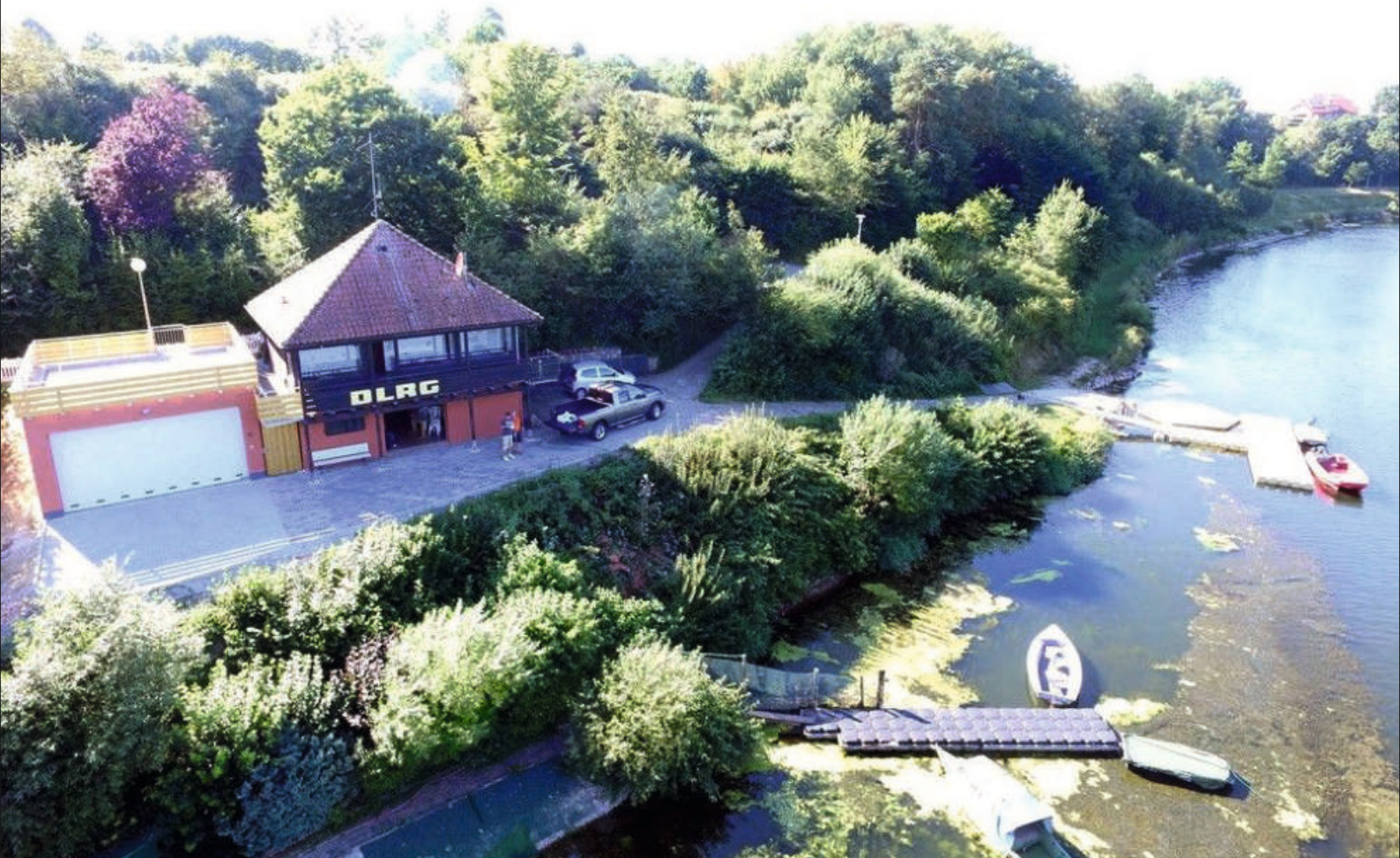
Luftbild der erneuerten und erweiterten Anlage mit den Bootsanlegern. (Foto: Stadt Bad Arolsen)
