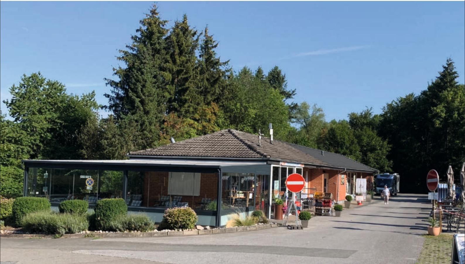
Saniertes Sanitärgebäude mit Erweiterung.
