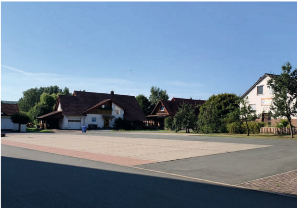
Neu angelegte Parkplatzfläche und Abstellmöglichkeiten für Fahrräder.
